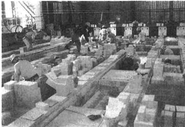
改修現場でレンガを積み築炉工(大和工業提供)
